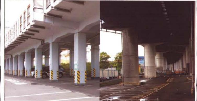
駅が近くにあるため人通りが多い。高架下の高さは低く、幅が狭い。この場合は2階をつくらず、柱との間に各部屋を設置する。道路をまたいでいるため交通量が多い。高架下の高さや幅が十分にあるため、2階をつくり各部屋を設置する。
